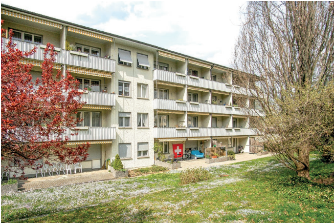
4 An der Balkonanordnung der Bauten lässt sich der grosse Wohnungsmix der Meienegg ablesen; hier befinden sich Ein- und Zweizimmerwohnungen.
