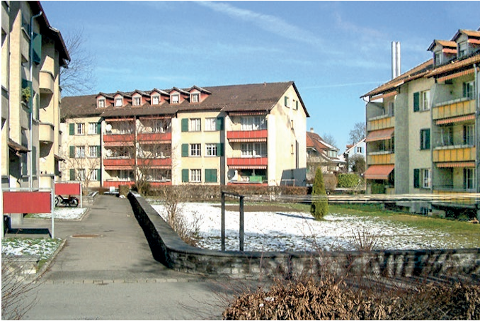
2 Die Siedlung Stöckacker (erbaut 1944–1946) war bis zu ihrem Abbruch 2013 der älteste Zeuge öffentlichen Wohnungsbaus der 1940er-Jahre in Bern.
