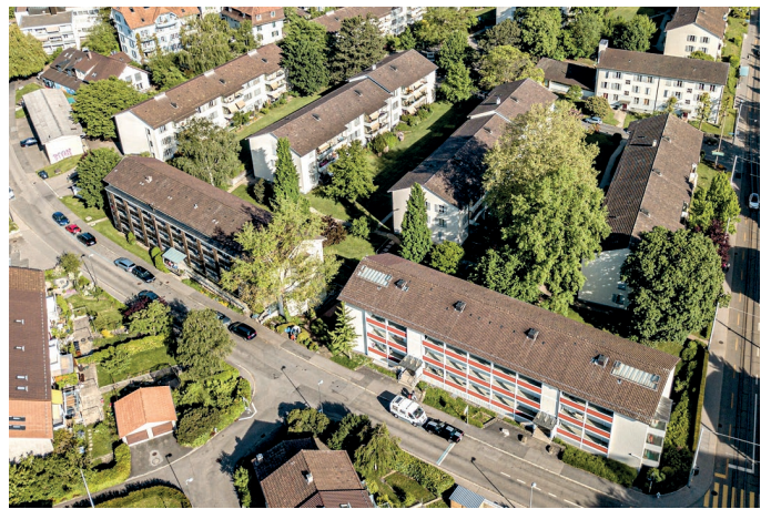
7 Am nordwestlichen Rand wurde die erste Alterssiedlung Berns integriert. Die beiden Häuser weisen als einzige keine Treppenhaus-, sondern eine damals neuartige, äussere Laubengangschliessung auf.
