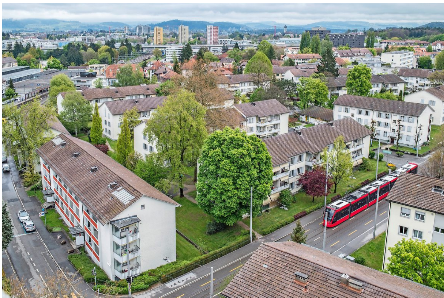
Höher, dichter und zu wesentlichen Teilen neu: Die Siedlung Meienegg soll transformiert werden. Foto: Franziska Rothenbühler
